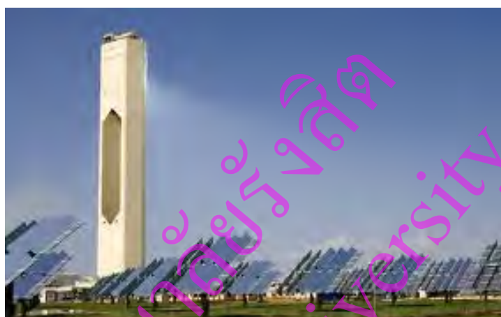
รูปที่ 2.10 Solar thermal tower
