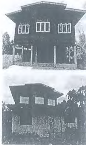
ภาพประกอบที่ 5.14 รูปแบบบ้านพักอาศัยชุมชนเริ่มนำคอนกรีตมาก่อสร้างชั้นล่าง
