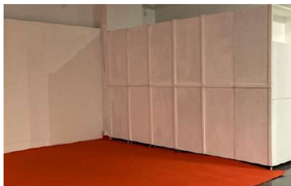
ภาพที่ 81 ภาพแสดงโครงสร้างผนังกันด้าน C เมื่อติดตั้งเสร็จ
