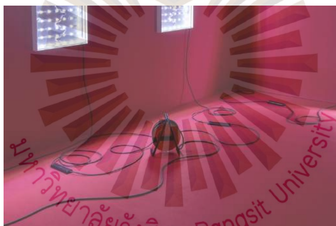
ภาพที่ 85 รูปแบบของการจัดวางสายไฟในพื้นที่จัดแสดง
