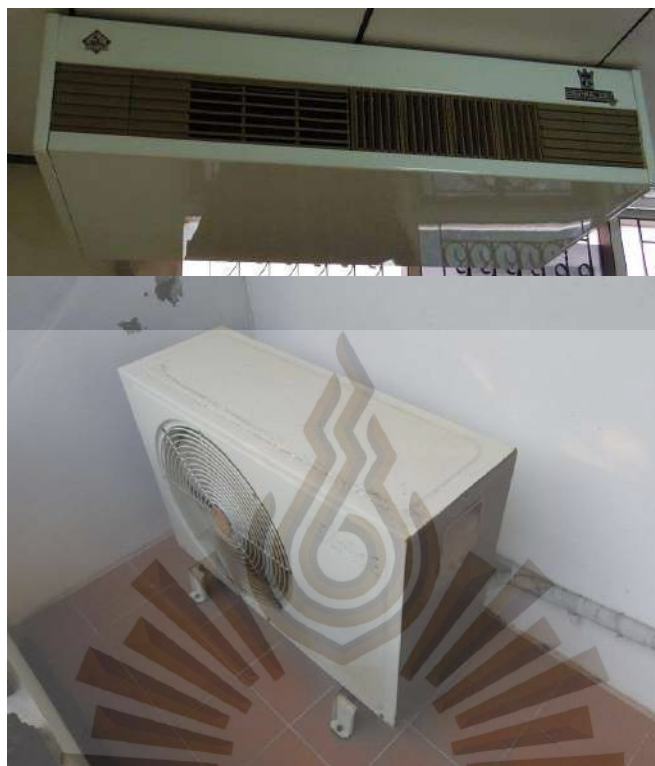
รูปที่ 3.4 เครื่องปรับอากาศ CENTRAL AIR รุ่น SF-FA-SERIES
