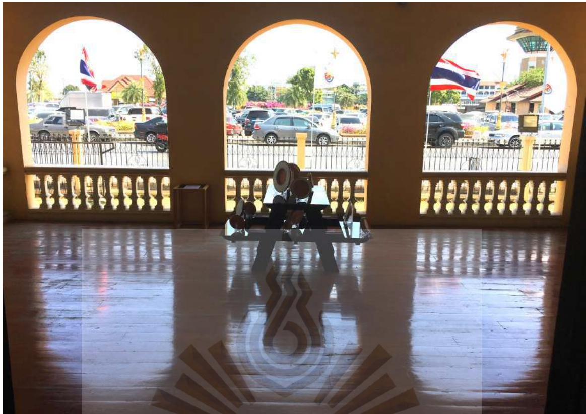
ภาพที่ 5.14 การติดตั้งเสร็จสมบูรณ์ มุมมองจากภายในอาคาร
