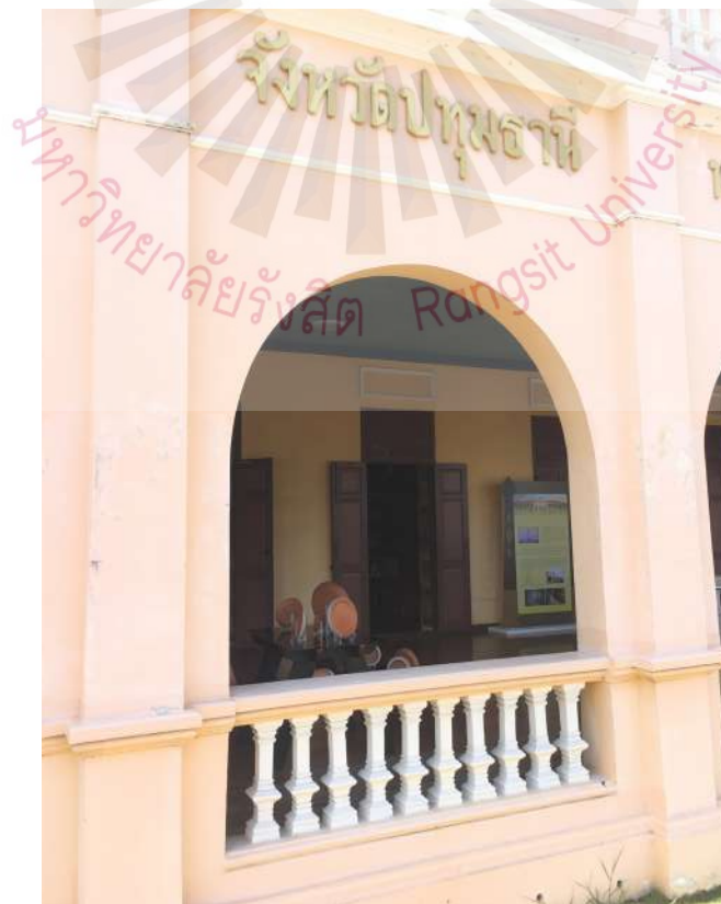
ภาพที่ 5.15 การติดตั้งเสร็จสมบูรณ์ มุมมองจากภายนอกอาคาร
