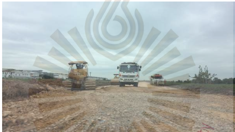
ภาพที่ 4.22 การปรับปรุงที่ดินเพื่อการก่อสร้าง ริมถนนลำลูกกา
