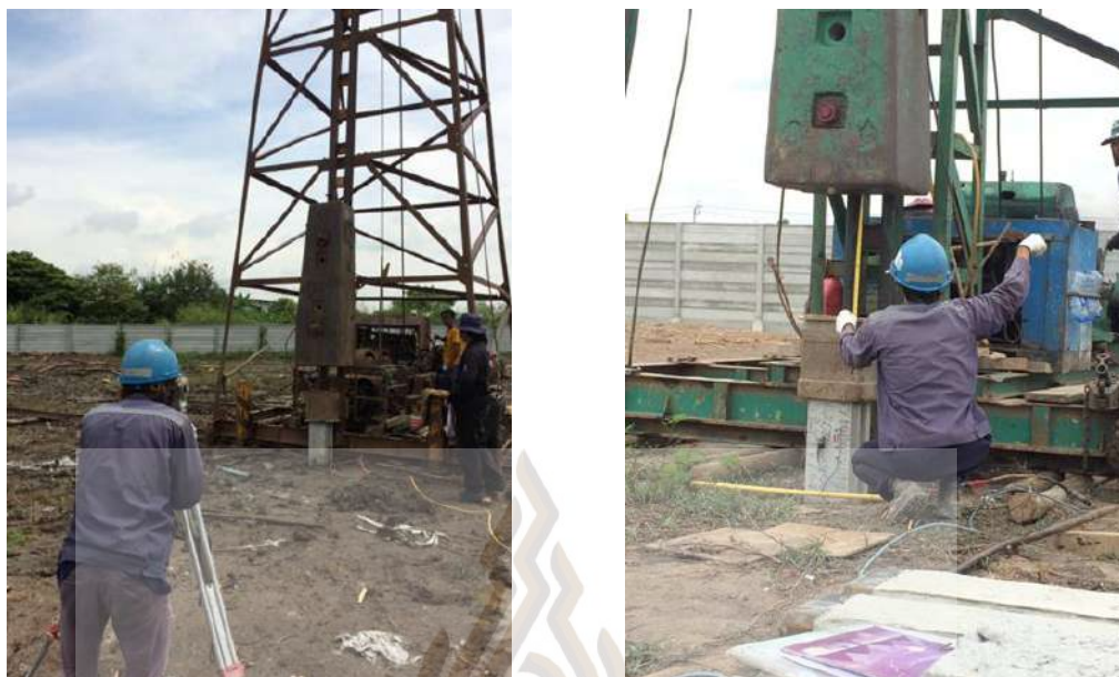
รูปที่ 3.8 การทดสอบกำลังของเสาเข็มแบบพลศาสตร์ ที่มา : ผู้วิจัย ,2565
