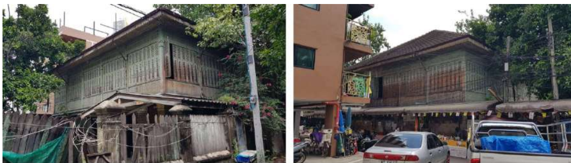
ภาพด้านข้างอาคาร
