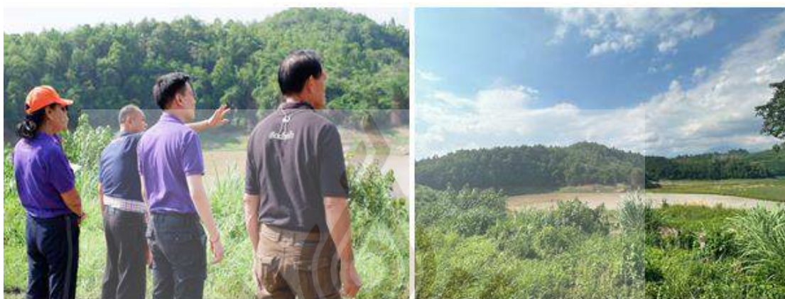
จุดที่ 1 อ่างเก็บน้ำห้วยยาง
