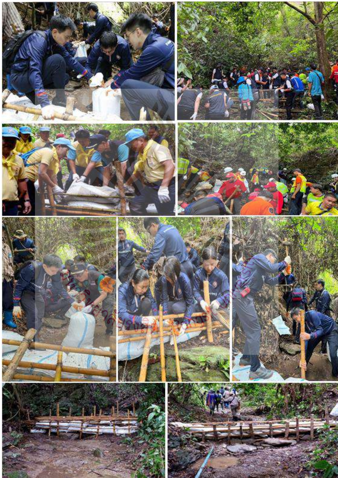
กิจกรรมสร้างฝาย ณ บริเวณฝายห้วยเย็น บ้านมอน หมู่ 3 ต.วรรณคร อ.ปัว จ.น่าน
