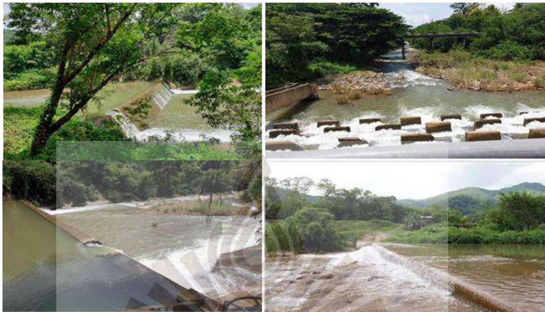
ภาพการบริหารจัดการน้ำ ฝายเก็บกักน้ำพัฒนาจากฝายไม้เป็นฝายซีเมนต์
