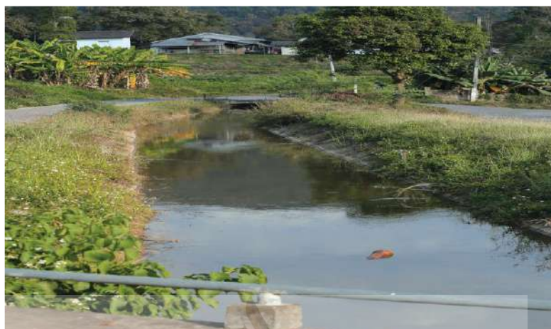
รูปที่ 4.4 ลำเหมืองใหม่ ดาดคอนกรีต ทำเป็นท่อขนาดใหญ่ลอดตัดผ่านถนน
