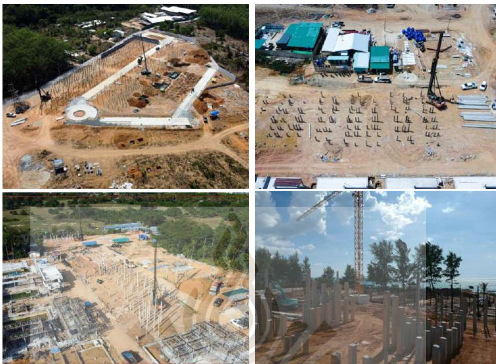
รูปที่ 2.18 แสดงงานติดตั้งเสาเข็ม (ต่อ) ที่มา: บริษัท นลองคอนกรีต 1999 จำกัด, 2567
