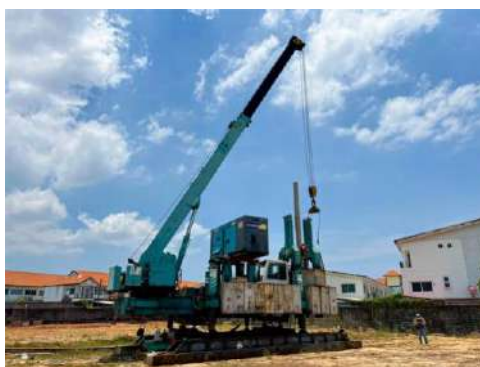
รูปที่ 2.18 แสดงงานติดตั้งเสาเข็ม
