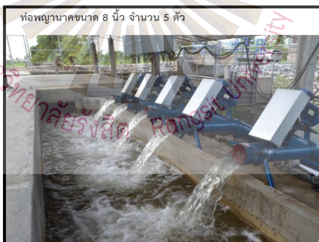
รูปที่ 4.2 รูปแบบการพัฒนาาระบบกระจายน้ำด้วยพลังงานแสงอาทิตย์ขนาดสูบน้ำไม่น้อยกว่า 1,800 ลูกบาศก์เมตรต่อวัน
