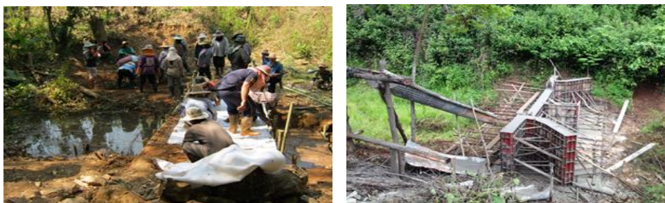
รูปที่ 4.7 การทำฝาย เพื่อพัฒนาด้านแหล่งน้ำกินใช้เพื่อการเกษตรโหล่งขอด
