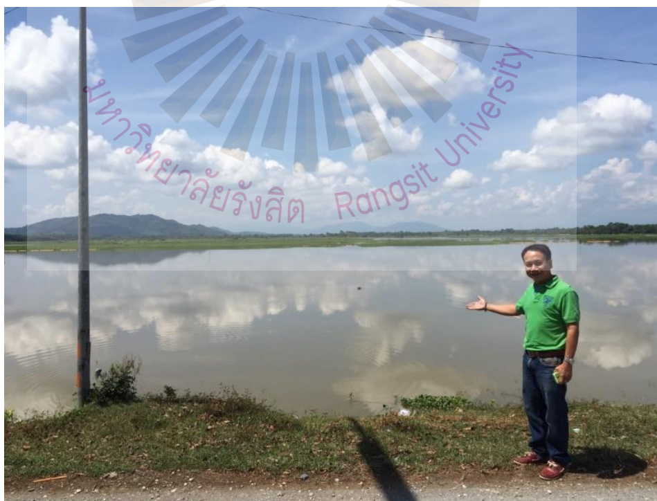
รูปที่ 4.8 เขื่อนปัตตานี ตำบลตาชะ อำเภอมือง จังหวัดปัตตานี
